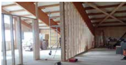
Rohbau Obergeschoss (Büroräume)
